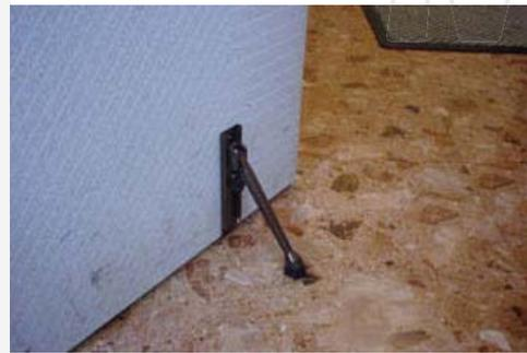
強風の時などドアが不安定状態で交換作業されますと大けがに結びつく恐れがありますので、絶対になさらないで下さい。作業終了まで半開きで固定できるように工夫して下さい。作業途中でドアが閉まってしまうと入室できなくなります。ドアストッパーなどでしっかり固定して動かない状態にしてから交換作業されることをお勧め致します。
