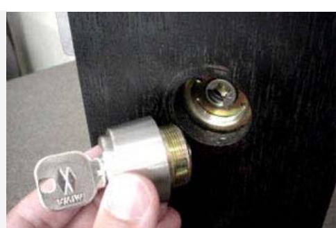
ネジが緩みしたら、現在使用しているキーを差し込みます。
