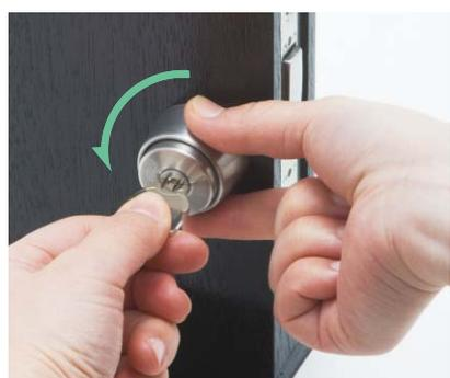
④ キーを押えながらシリンダーリングを持って左方向（反時計回り）へ回します。
