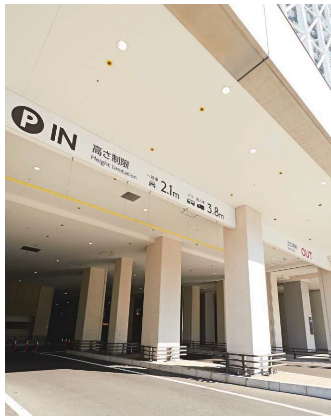
サイン 施工 実績例
