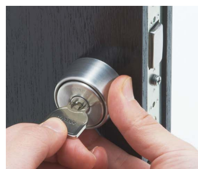
⑥ シリンダーをねじ込むときは一杯まで回し切り、写真のようにMIWAの刻印が上になる位置まで戻してください。この位置が正確でないとシリンダー止めネジが入りません。
