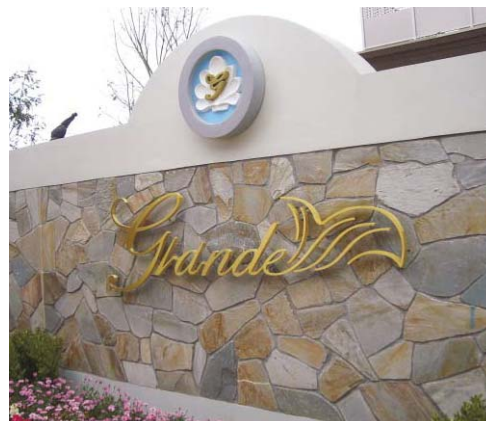
上：GRC成形塗装仕上 下：ステンレス箱文字焼付塗装
