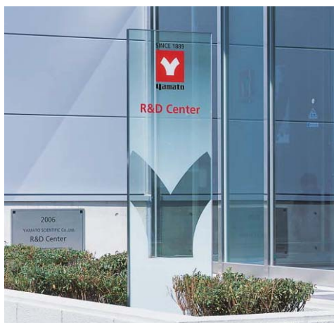
強化ガラス合せ加工、シルク印刷（グラデーション）
