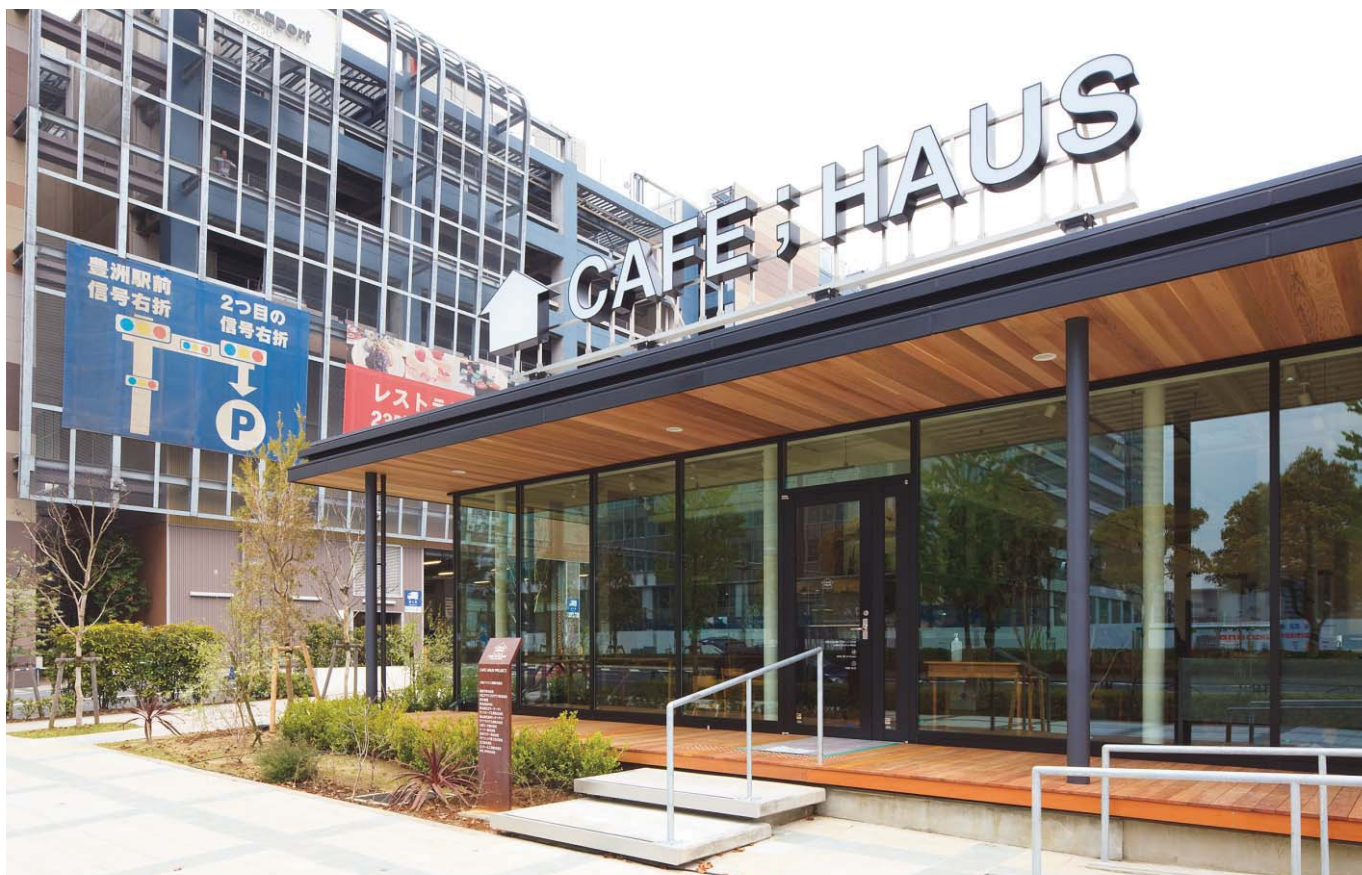
ステンレス箱文字加工焼付塗装仕上、アクリル乳半加工、LEDユニット内蔵（支持：ステンレス鋼材加工、HL仕上）
