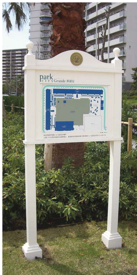
GRC成形塗装仕上、シート切文字、インクジェット出力 貼り
