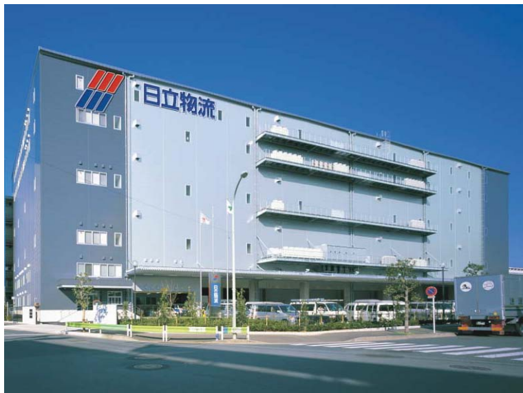
亜鉛引き鉄板折曲加工、シート貼り、塩ビ乳半、透過性シート貼り、LED内照式
