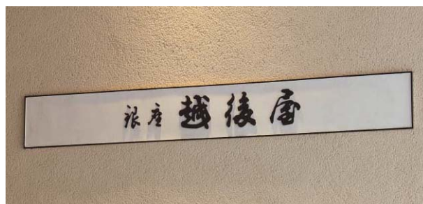
ステンレスFB加工焼付塗装仕上、ステンレス切文字加工焼付塗装仕上
