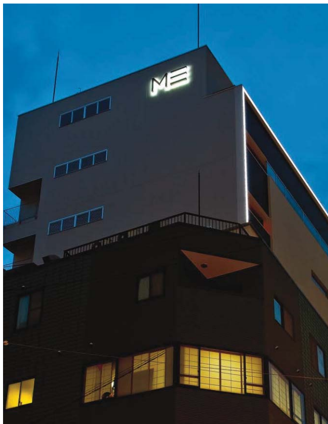
ステンレス箱文字、焼付塗装仕上、バックライト (LED)
