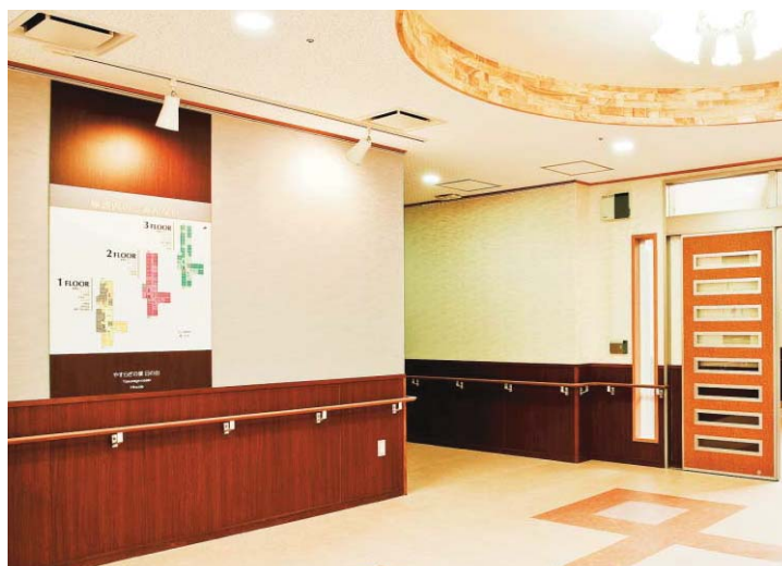
アルミ複合板、インクジェットシート、ダイノックシート貼り
