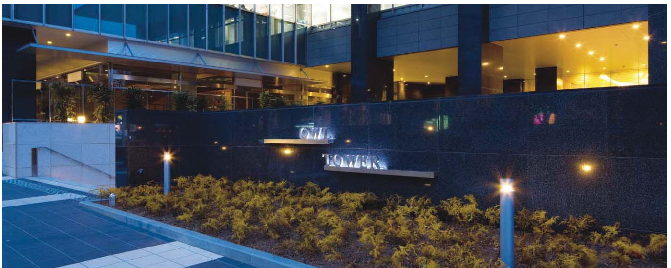
文字：ステンレス箱文字加工、HL 仕上／照明：高輝度LED内蔵
