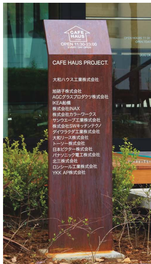
スチール折曲加工錆塗装仕上、塩ビシート切文字加工貼り
