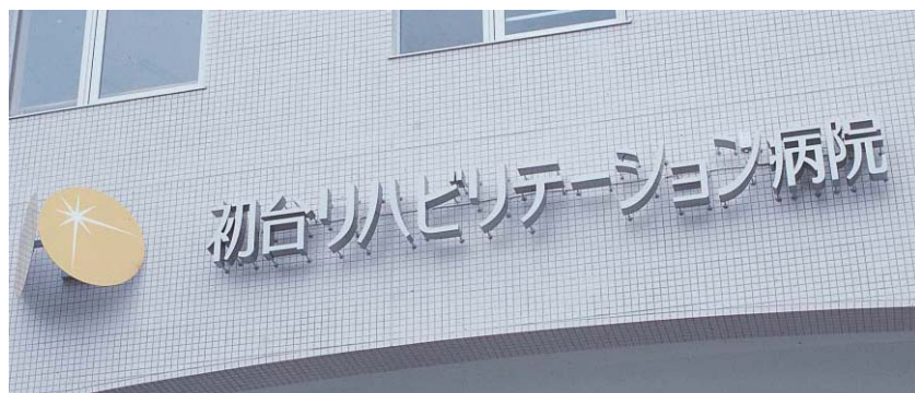
ステンレス箱文字加工、HL仕上（バックネオン）
