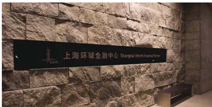
スチール折曲加工、焼付塗装＋ステンレス切文字加工HL仕上
