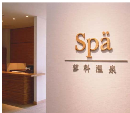
木材切文字着色仕上、ステンレス切文字、パイブレーション仕上
