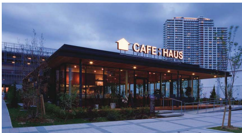
ステンレス箱文字加工焼付塗装仕上、アクリル乳半加工、LEDユニット内蔵（支持：ステンレス鋼材加工、HL仕上）
