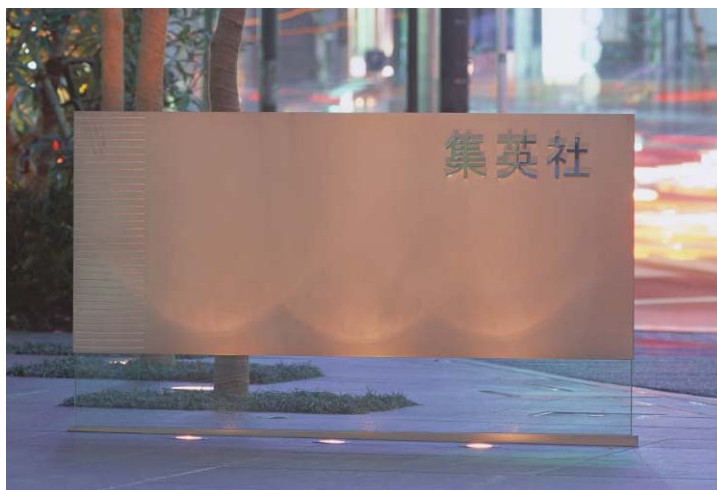
強化ガラス、ステンレス折曲加工、ビーズブラスト仕上、ステンレス切文字鏡面仕上
