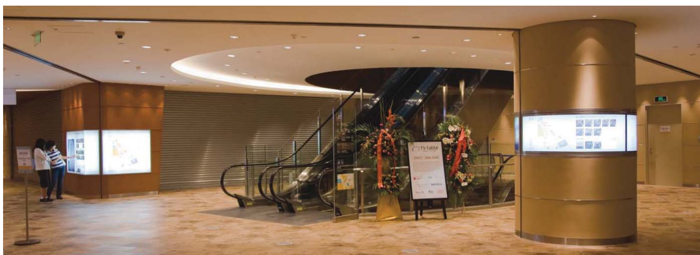
スチール枠加工、焼付塗装、乳半アクリル板透過性、インクジェット出力シート貼り、FL管内蔵
