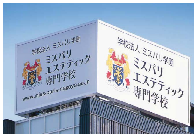
スチール加工溶融亜鉛メッキ仕上、不燃材FFシート張り+塩ビシート貼り、FL内照式
