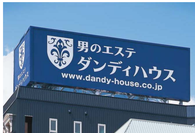
スチール加工溶融亜鉛メッキ仕上、不燃材FFシート張り+塩ビシート貼り、FL内照式
