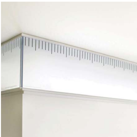
塩ビシート貼り
