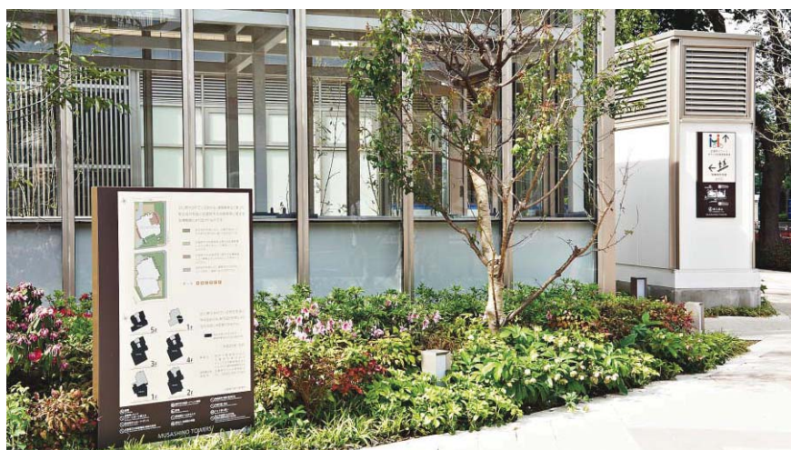
ステンレス加工品焼付塗装仕上、インクジェットシート貼り
