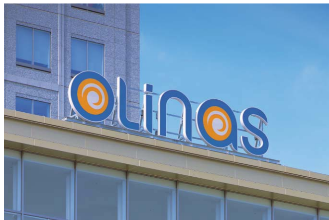
ステンレス箱文字焼付塗装、塩ビ乳半 透過性シート貼り、ネオン管内照式
