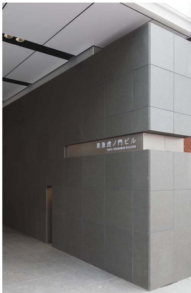
ステンレス折曲加工焼付塗装仕上、アクリル乳半裏当て加工、LEDユニット内蔵
