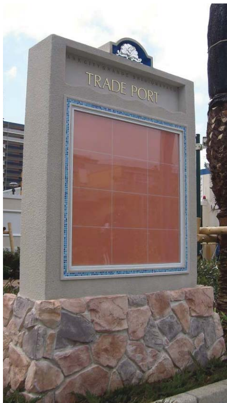
GRC成形+石材貼り、FL内照式、ステンレス切文字 焼付塗装、アクリル板加工+インクジェット出力貼り
