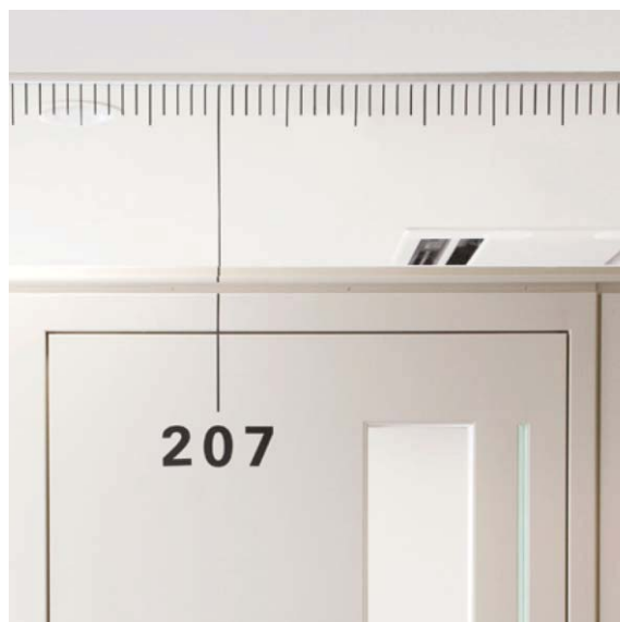
塩ビシート貼り
