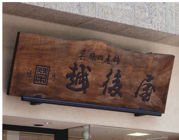
LEDユニット内蔵照明（ステンレス鋼管加工焼付塗装仕上） ※既存看板利用
