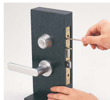
3. シリンダー止めピンを完全に引き抜きます。
