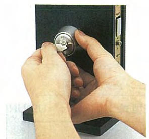
7. シリンダーをねじ込むときは一杯まで回しきり、写真のようにMIWAの刻印が上になる位置まで戻してください。この位置が正確でないとシリンダー止めネジが入りません。
