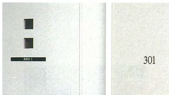
アクリル板シルク印刷、真鍮切文字塗装
