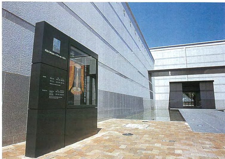
本体ステンレス焼付塗装、ステンレス切文字 照明付ポスターケース
